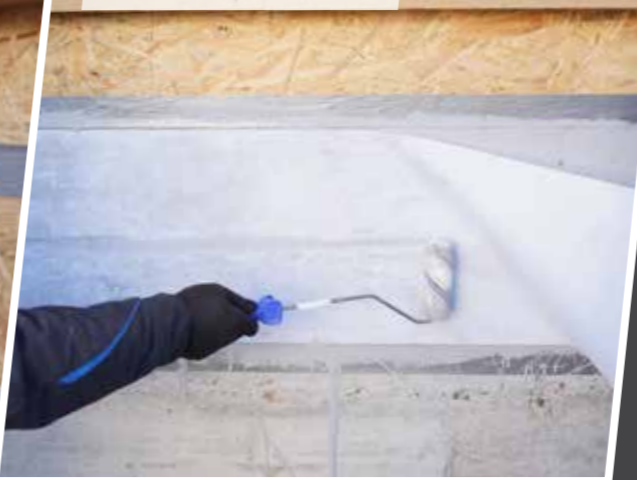
3. Zweite Lage auftragen und Klebeband entfernen.
